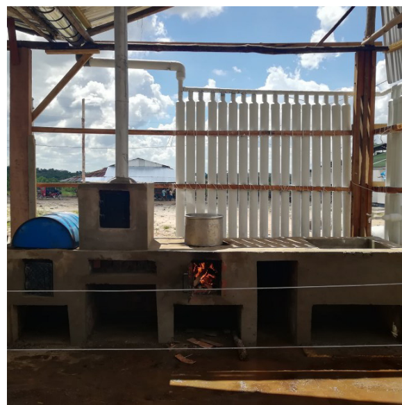
Figura 6. Cocina mejorada en la maloca.
