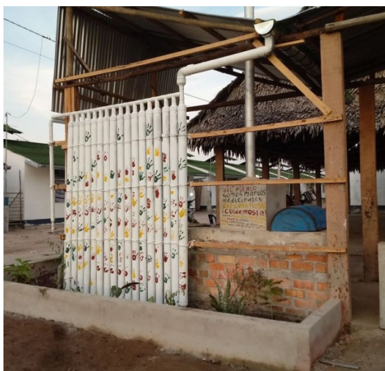
Figura 5. Celosía almacenadora de lluvia en la maloca.
