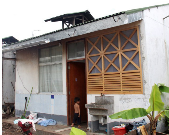
Figura 4. Ventana ventilada en una vivienda.
